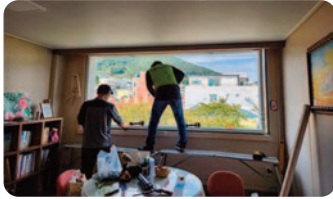
열효율개선사업 샷시 교체 공사 (10.16)
